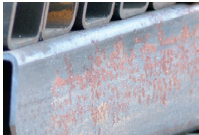
прямоугольная стальная труба перед пескоструйной очисткой
